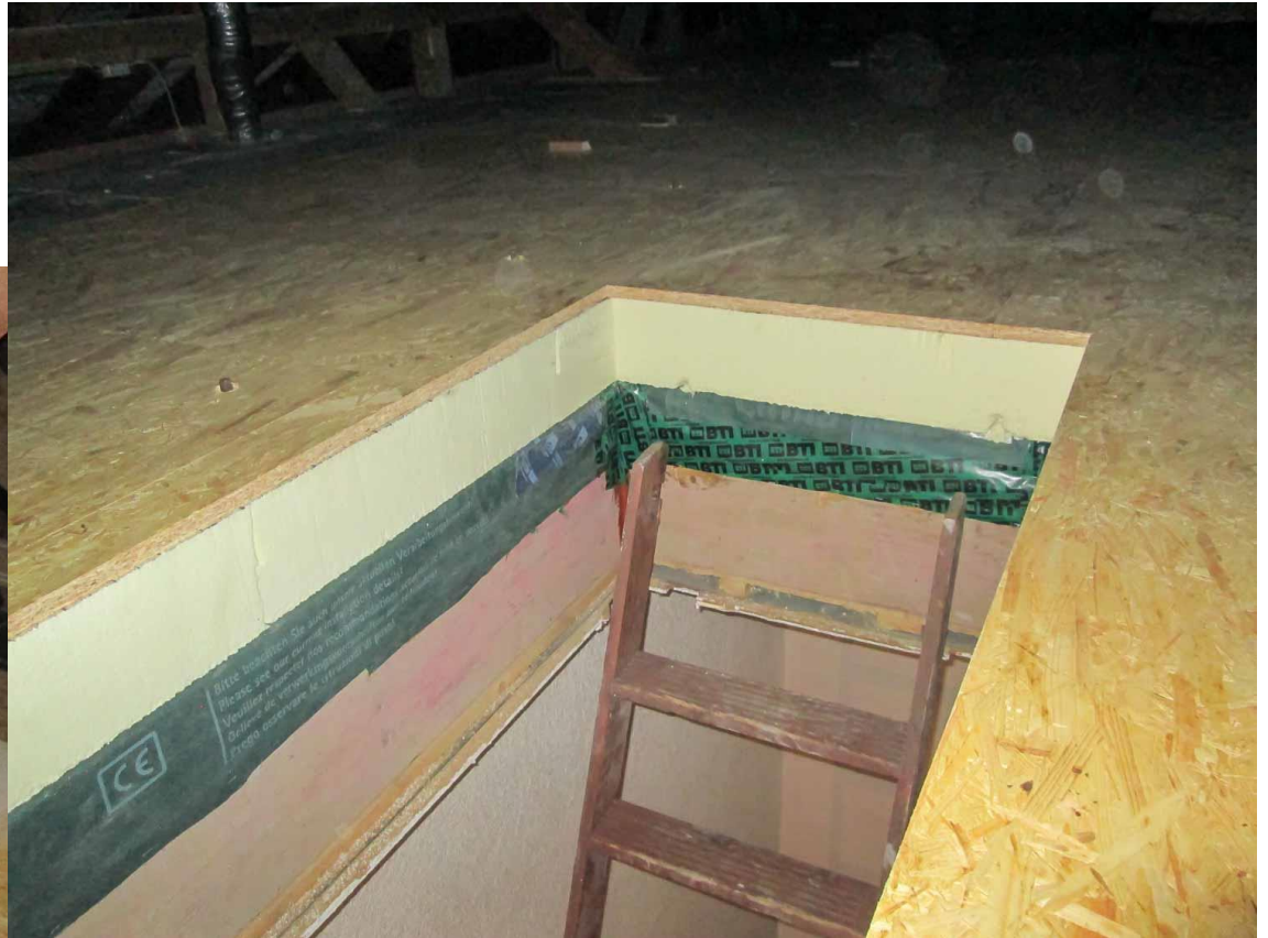
PU-Dämmung über Luftdichtbahn Neue PH-zertifizierte Bodentreppe noch nicht eingebaut
